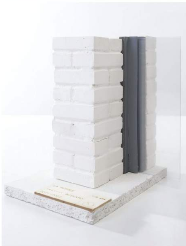
Maquette détail au 1/25 ème d'un poteau en brique avec menuiserie
