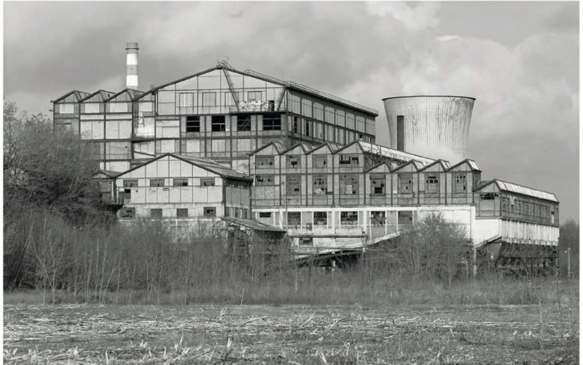
Photographie du Lavoir des Chavannes |
