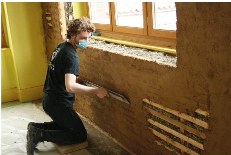
Photographie de la mise en oeuvre de l'isolation par Titouan Brossard
