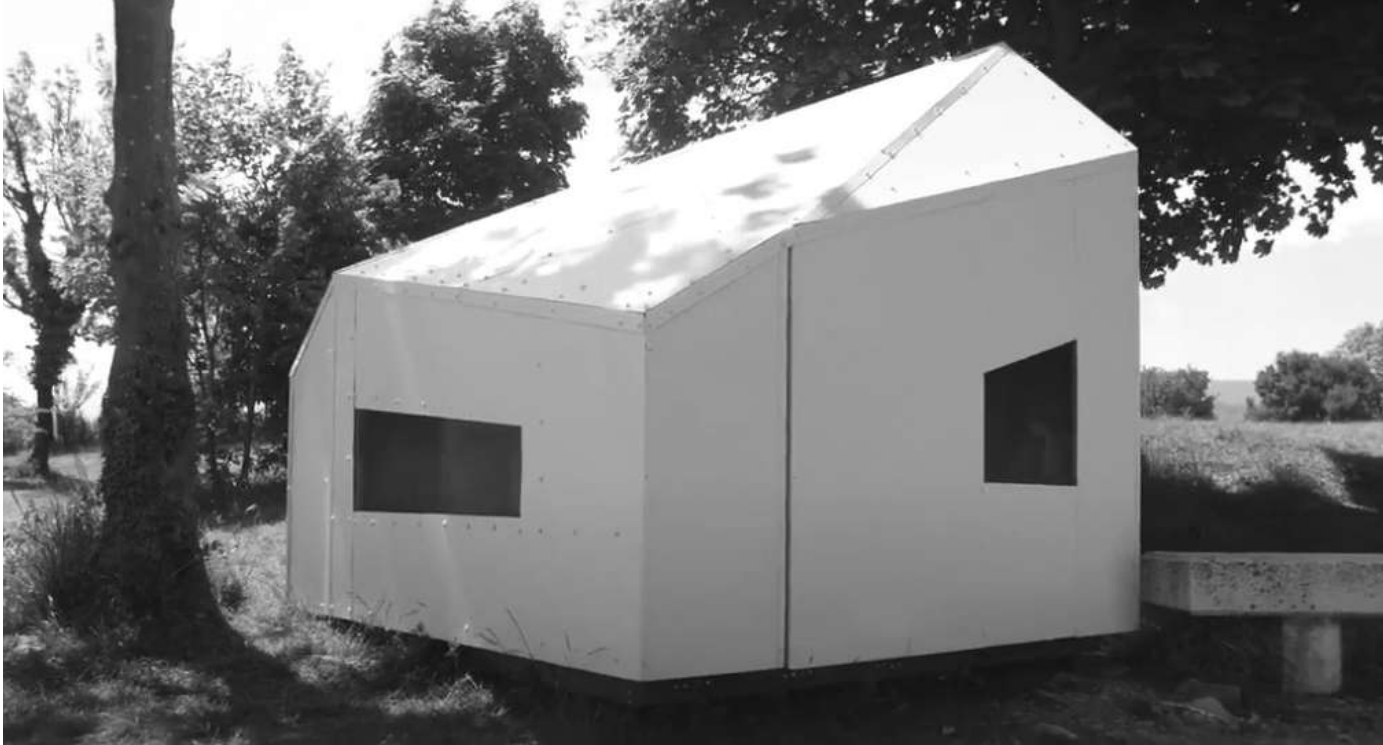
Photo : refuge installé sur le site, finition tôle en façade
