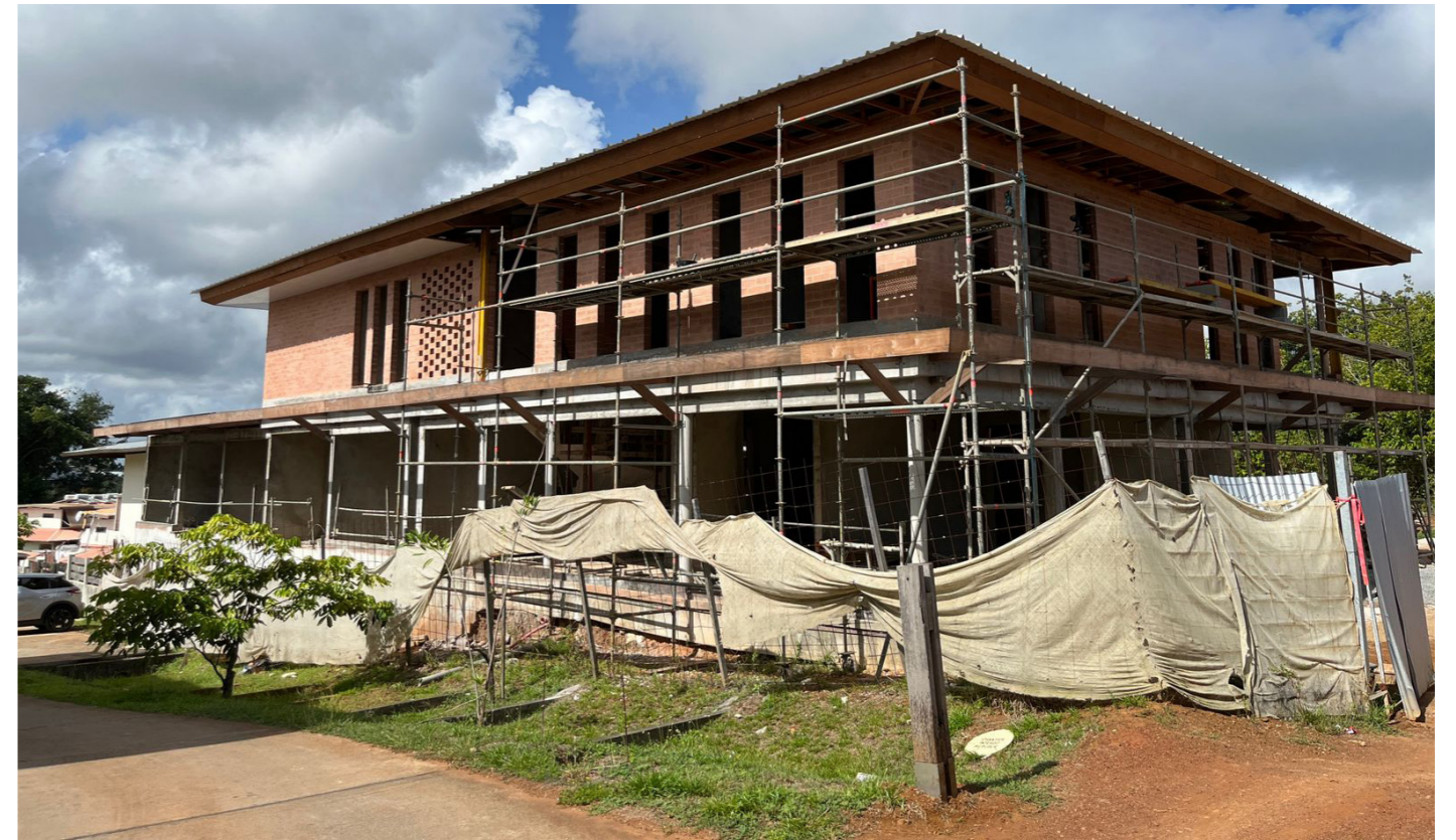
PHOTO - VUE DE L'ENTRÉE (en cours)
