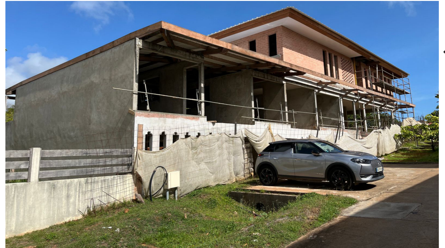
PHOTO - VUE SUR L'ENTRÉE DU PARKING
